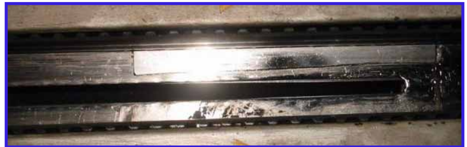
รางรองกันขูดที่เครื่อง 4
